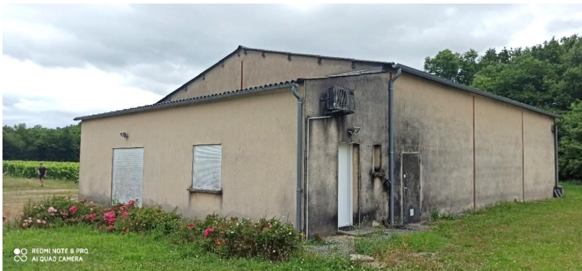
Photo n° 4 : Chai de vieillissement n°1
